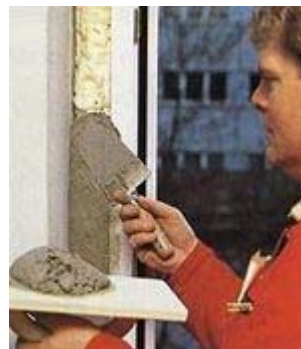
Der fertig fixierte Fensterrahmen kann zum Abschluss verputzt werden.
