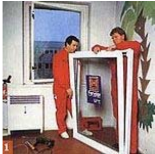
Der Rahmen wird vom Fenster getrennt.
