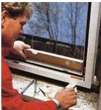
Vorher zugeschnittene Holzklötzchen sorgen für einen waagerechten Sitz des Fensters.
