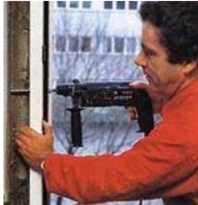
Bohrungen markieren die Befestigungspunkte des Fensterrahmens.
