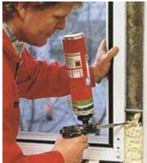
Den letzten Halt bekommt das Fenster durch das Ausspritzen des Zwischenraums mit Montageschaum.
