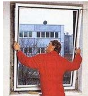
Der Fensterrahmen wird in den Fensterausschnitt gesetzt.
